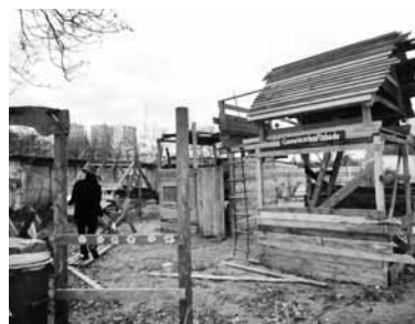
写真2 廃材で家づくり
